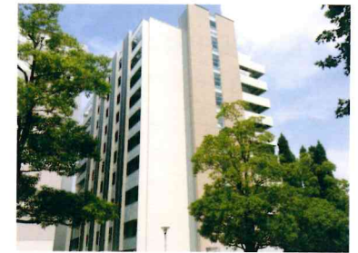
名古屋大学大学院 医学系研究科 医系研究棟3号館：名古屋市
