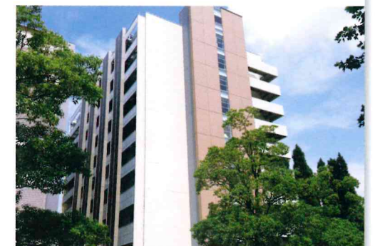
名古屋大学大学院 医学系研究科 医系研究棟3号館
